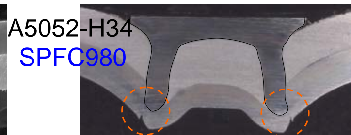
(b) 下板割れ
