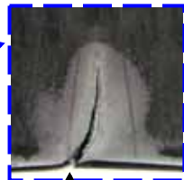
フランジ割れ
